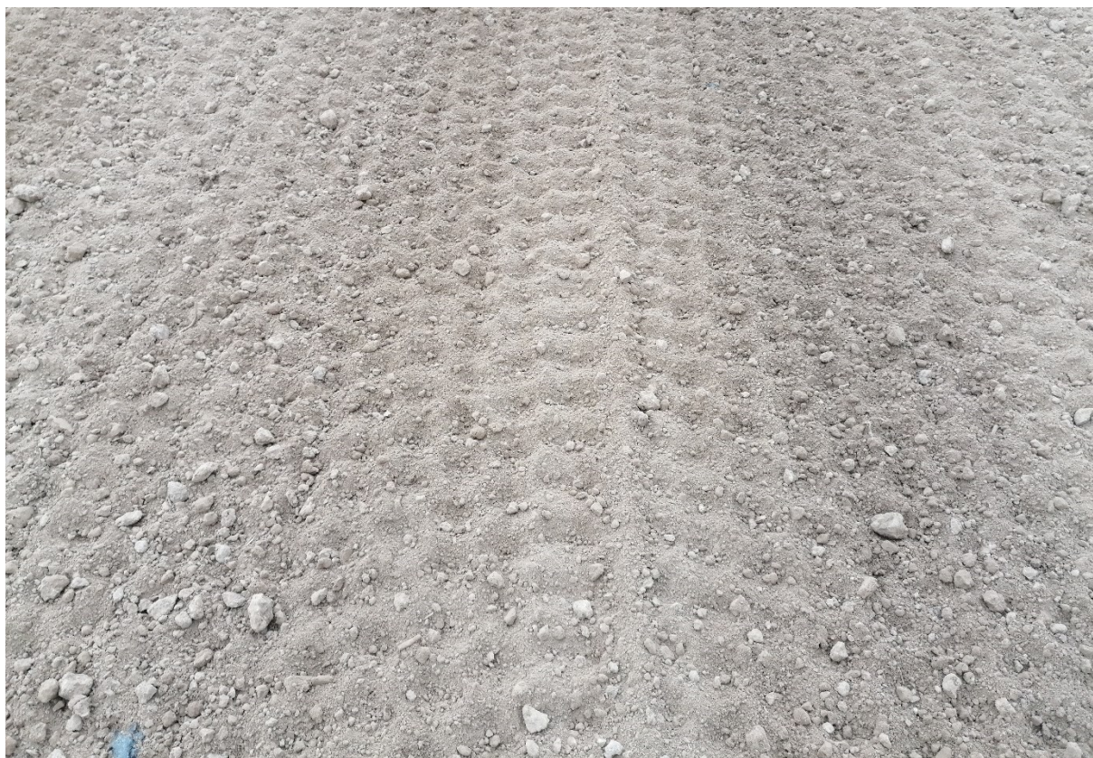
Figuur 10. Bodem na 3 passages met de compactor, foto 29 maart 2022.
