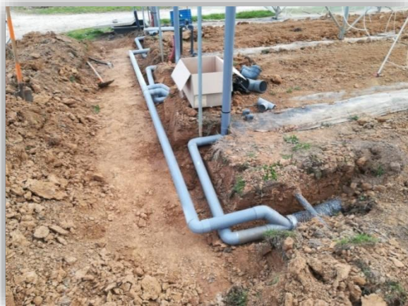
Figuur 31. – Systeem voor infiltratie van hemelwater in het gangpad.
